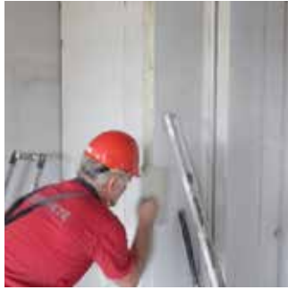
Passo 5 Colagem das conexões dos painéis
