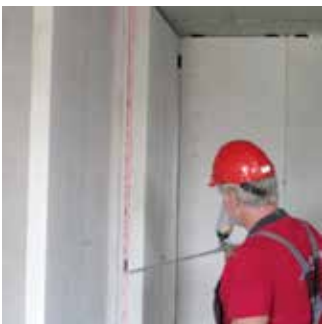
Passo 13 Preenchimento das junções com espuma
