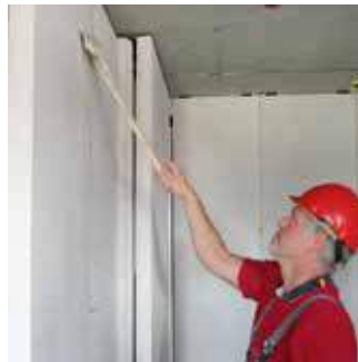
Passo 11 Remoção de excesso de cola das junções
