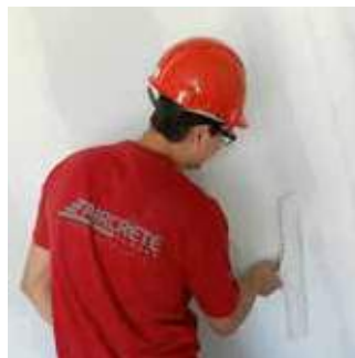
Passo 15 Aplicação de massa nas junções (1mm); O restante da parede está pronta para receber a pintura ou papel.
