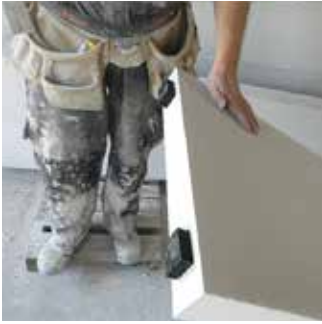
Passo 4 Instalação das borrachas
