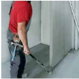
Passo 8 Utilização da ferramenta de fixação
