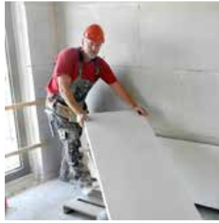
Passo 3 Transporte para o local de instalação
