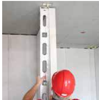
Passo 9 Checagem do alinhamento
