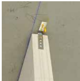
Passo 12 Instalação do suporte de fixação, conectando o painel ao teto
