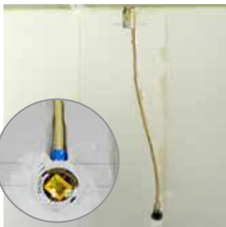
Passo 14 Fresagem de canais para instalação de rede elétrica
