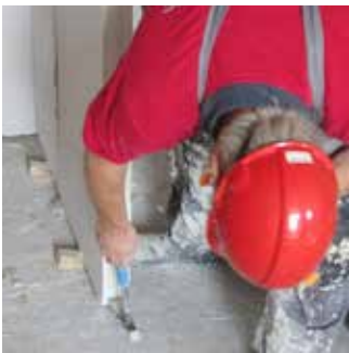
Passo 10 Instalação dos calços de madeira
